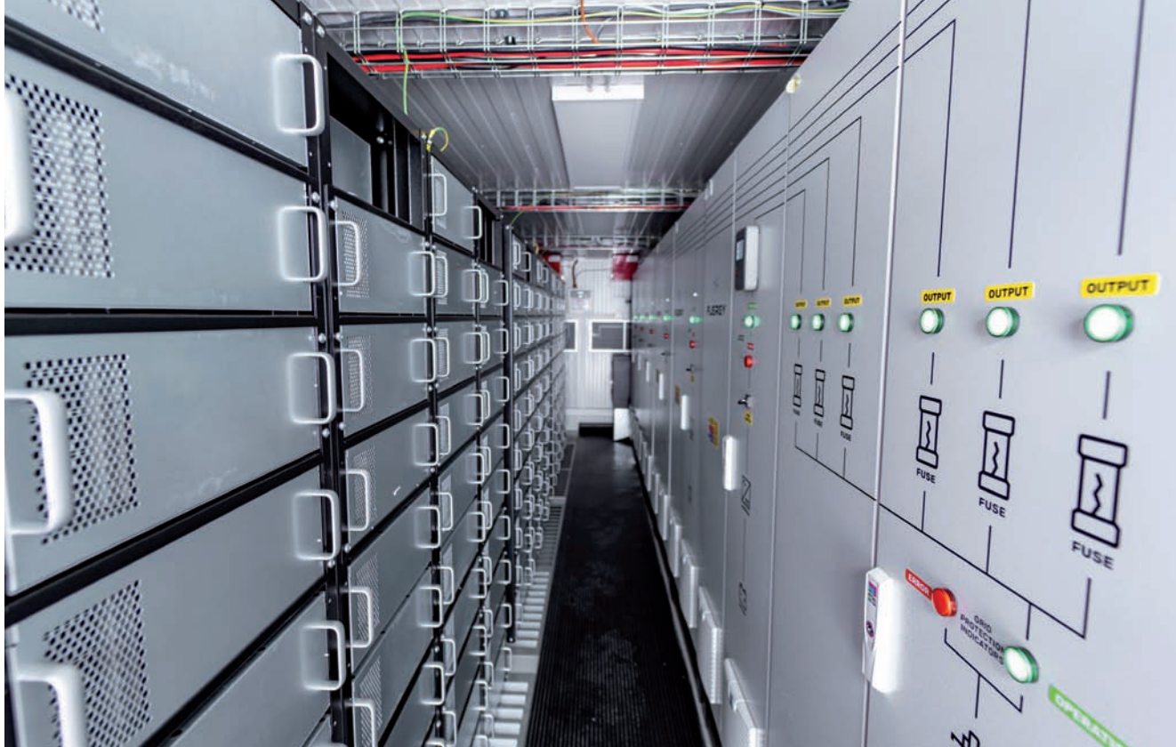
Základ úložiska tvoria nehorľavé LiFePO4 batériové moduly od spoločnosti Pylontech a meniče slovenskej spoločnosti VONSCH spol. s r. o.
