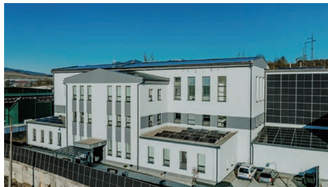
Budova rozvodne s inštalovaným batériovým úložiskom a fotovoltikou
